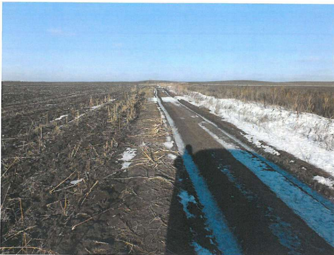
Илл. 18. Объект «Эксплуатационная скважина №5 Морецкого месторождения. Обустройство скважины №5 Морецкого месторождения» на территории Большеглушицкого района Самарской области. Подъездная дорога. Вид с ЮЮЗ.
