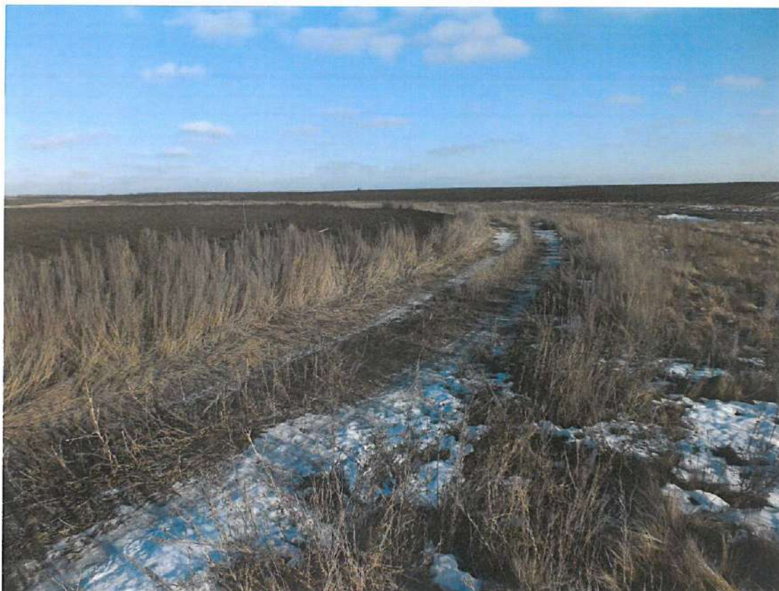
Илл. 28. Объект «Эксплуатационная скважина №5 Морецкого месторождения. Обустройство скважины №5 Морецкого месторождения» на территории Большеглушицкого района Самарской области. Подъездная дорога. Вид с ЮЮЗ.
