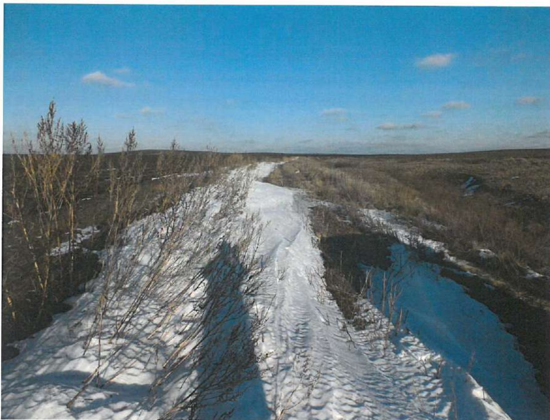
Илл. 24. Объект «Эксплуатационная скважина №5 Морецкого месторождения. Обустройство скважины №5 Морецкого месторождения» на территории Большеглушицкого района Самарской области. Подъездная дорога. Вид с ЮЮЗ.
