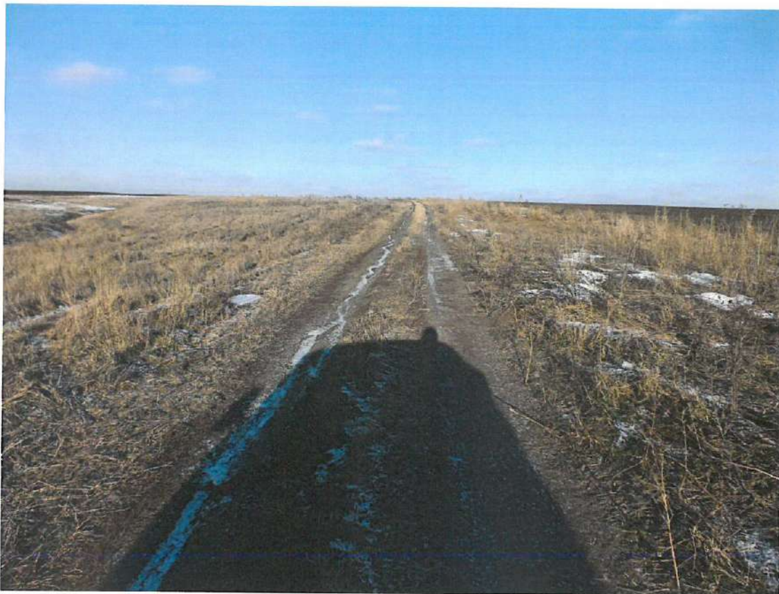
Илл. 34. Объект «Эксплуатационная скважина №5 Морецкого месторождения. Обустройство скважины №5 Морецкого месторождения» на территории Большеглушицкого района Самарской области. Подъездная дорога. Вид с ЮЮЗ.
