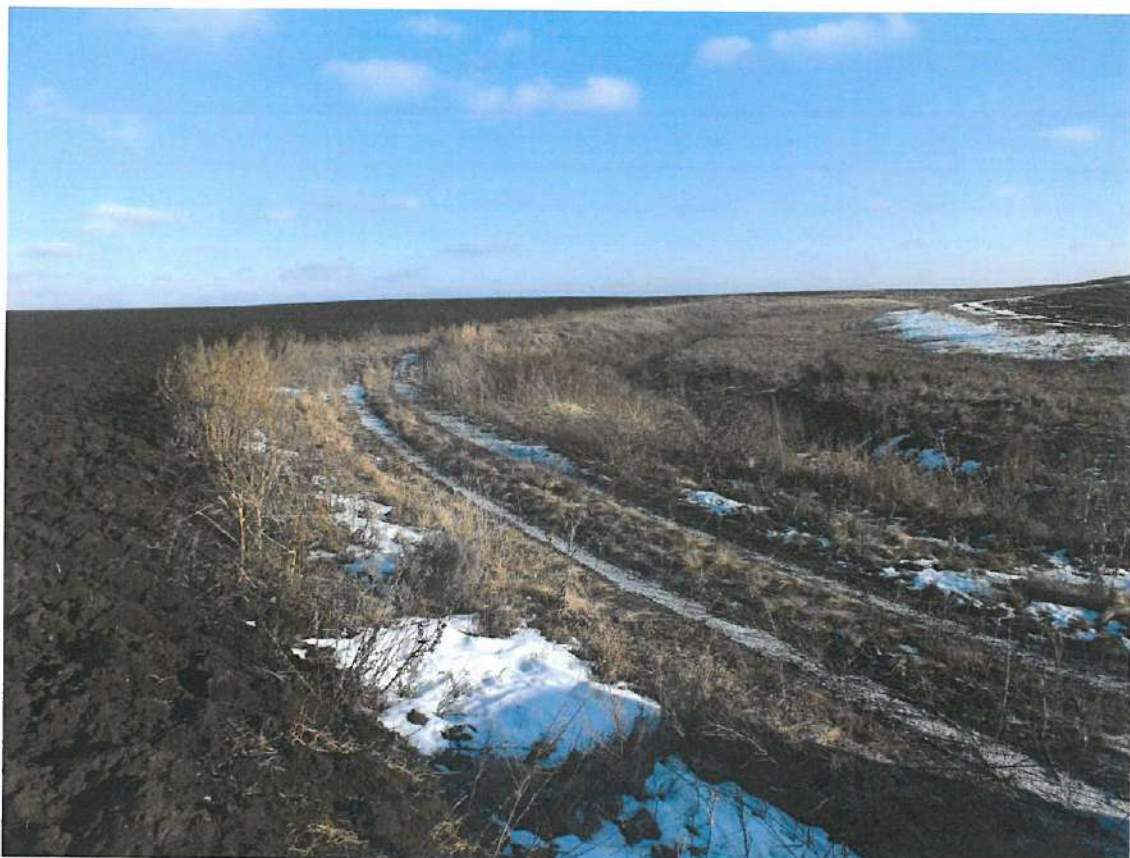
Илл. 26. Объект «Эксплуатационная скважина №5 Морецкого месторождения. Обустройство скважины №5 Морецкого месторождения» на территории Большеглушицкого района Самарской области. Подъездная дорога. Вид с ЮЮЗ.
