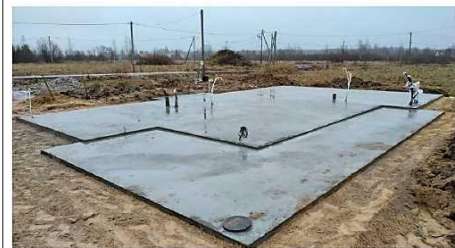
Фото №7 фундамент с коммуникациями
