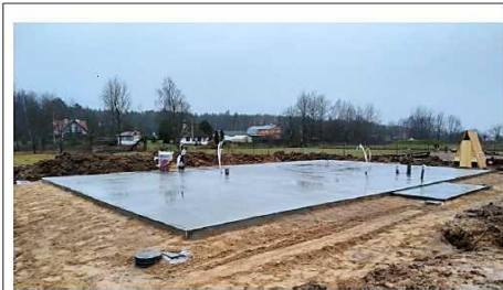
Фото №5 фундамент с коммуникациями
