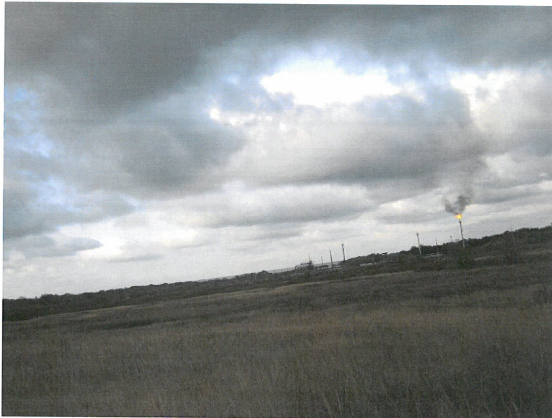
Рис. 6. Объект «Техническое перевооружение нефтесборного коллектора от АГЗУ № 1 Крюковского месторождения до ПНН «Крюковский». Нефтесборный коллектор. Вид с юга.
