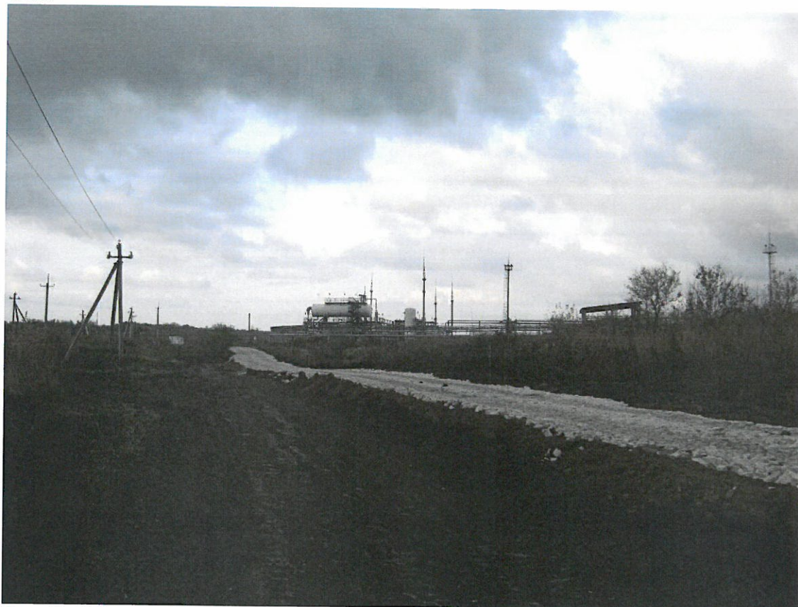
Рис. 8. Объект «Техническое перевооружение нефтесборного коллектора от АГЗУ № 1 Крюковского месторождения до ПНН «Крюковский». Нефтесборный коллектор. Вид с ЮЮВ.
