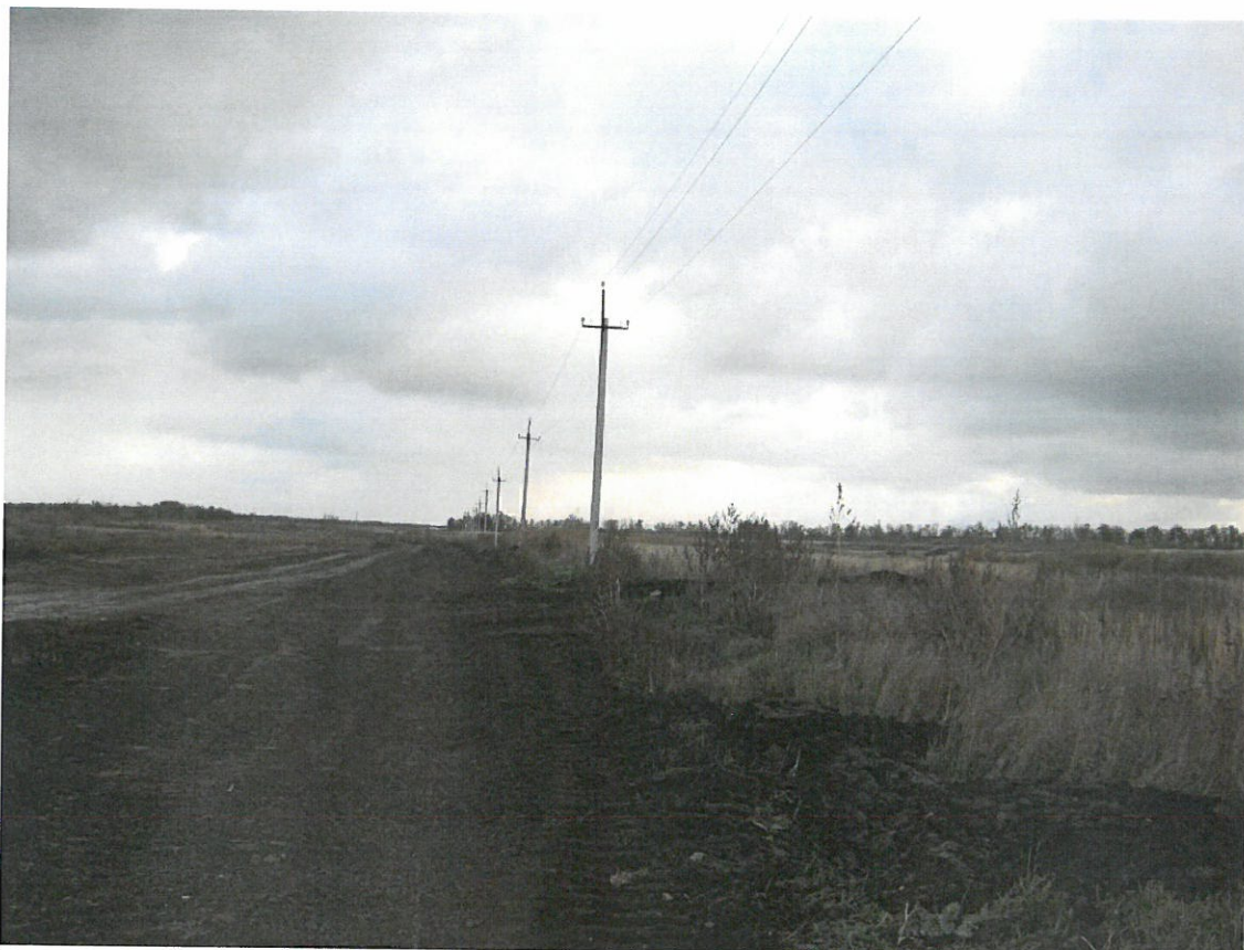
Рис. 7. Объект «Техническое перевооружение нефтесборного коллектора от АГЗУ № 1 Крюковского месторождения до ПНН «Крюковский». Нефтесборный коллектор. Вид с ССЗ.
