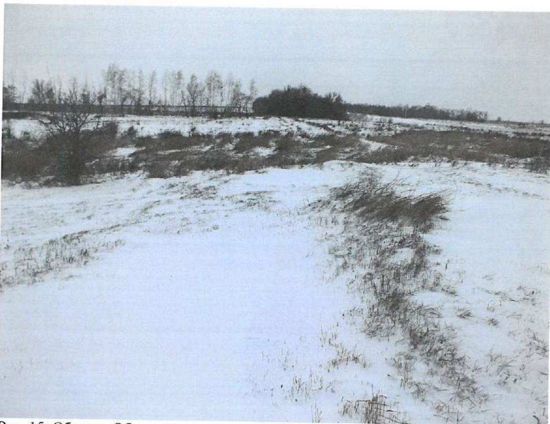
Рис. 15. Объект «Обустройство скважины № 25 Токолянского месторождения». Выкидной трубопровод и ВЛ. Переход через овраг Большой Кормежный. Вид с ВЮВ.
