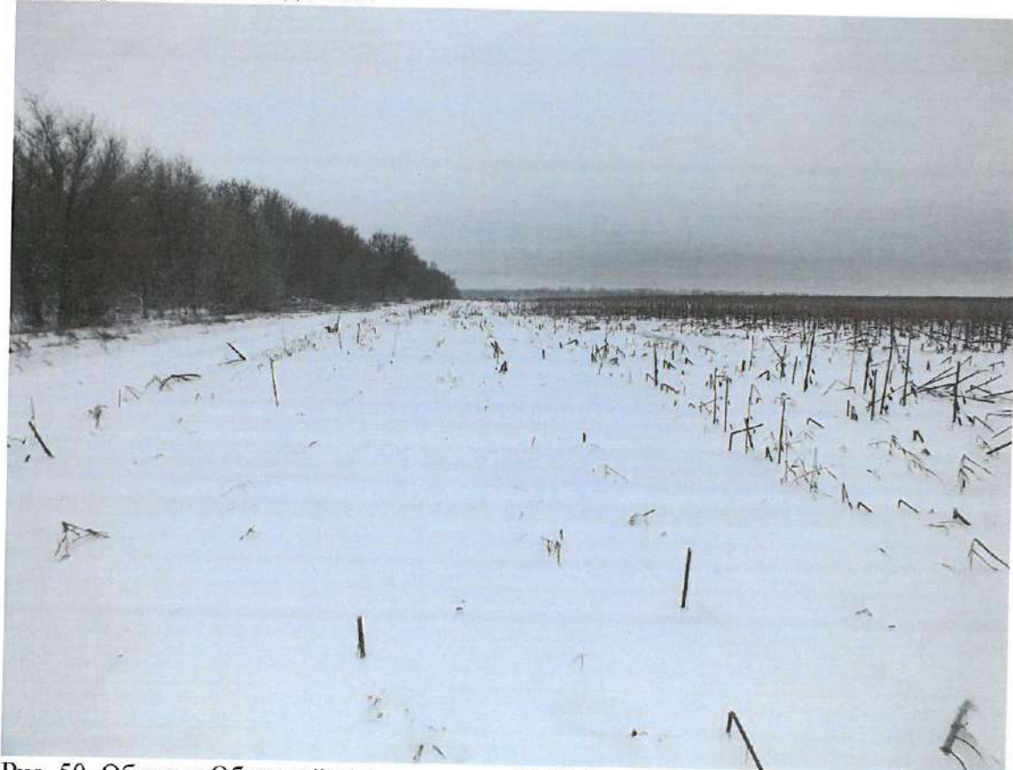
Рис. 50. Объект «Обустройство скважины № 25 Токолянского месторождения». Выкидной трубопровод и ВЛ. Вид с СВ.
