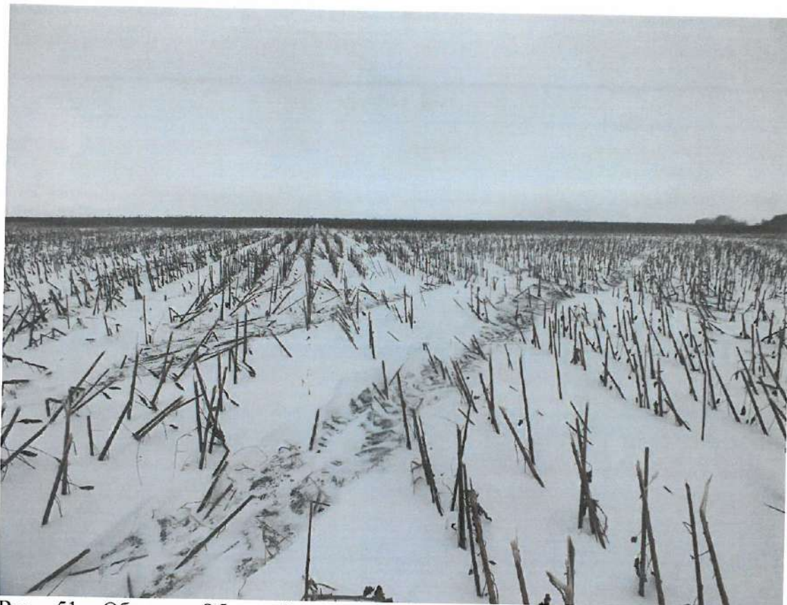
Рис. 51. Объект «Обустройство скважины № 25 Токолянского месторождения». Проектируемая площадка скважины № 25. Вид с Ю.
