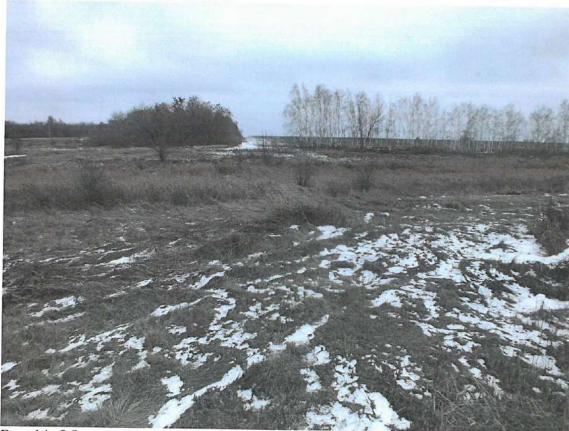
Рис. 14. Объект «Обустройство скважины № 25 Токолянского месторождения». Выкидной трубопровод и ВЛ. Переход через овраг Большой Кормежный. Вид с ЗСЗ.
