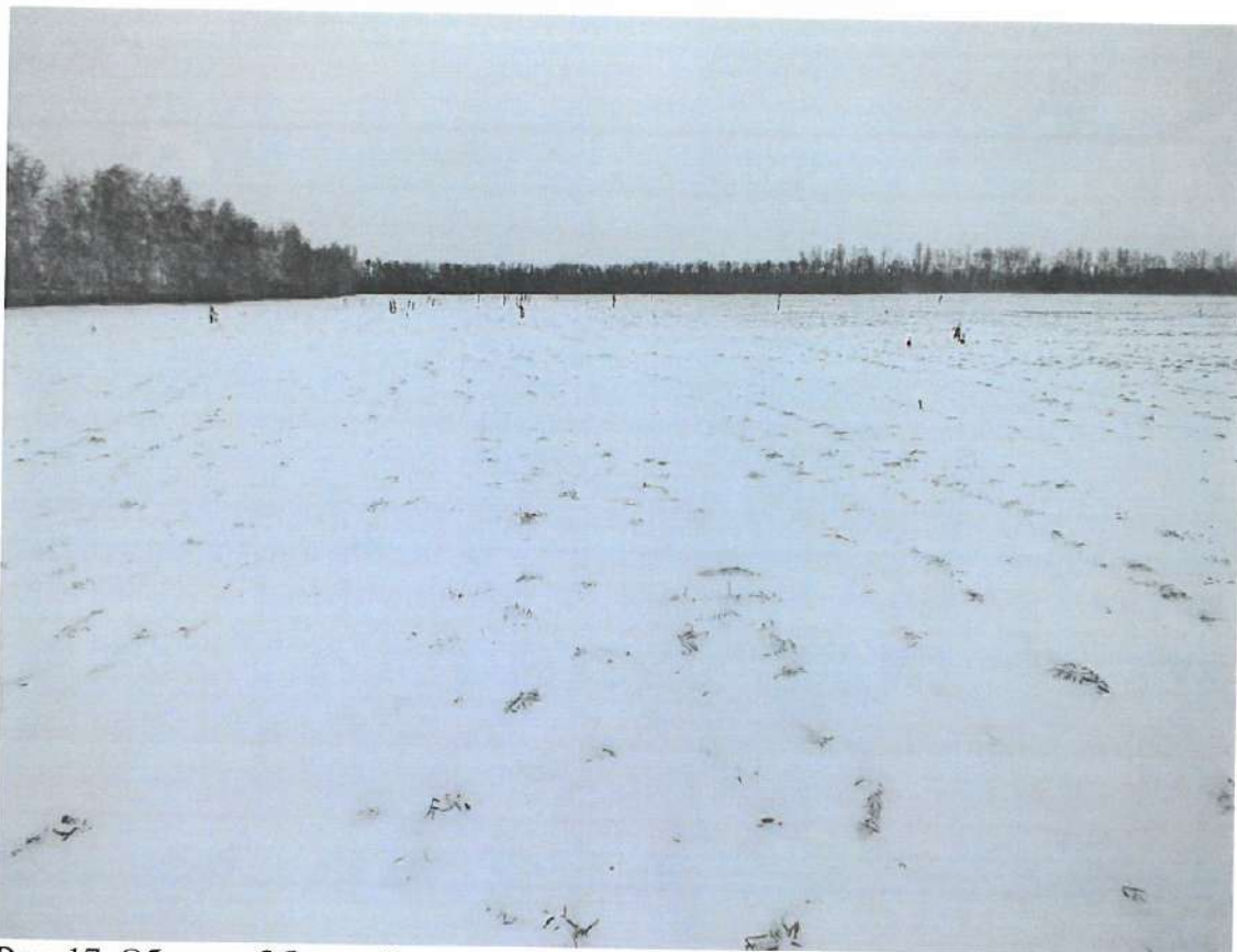
Рис. 17. Объект «Обустройство скважины № 25 Токолянского месторождения». Выкидной трубопровод и ВЛ. Вид с ЮЮЗ.
