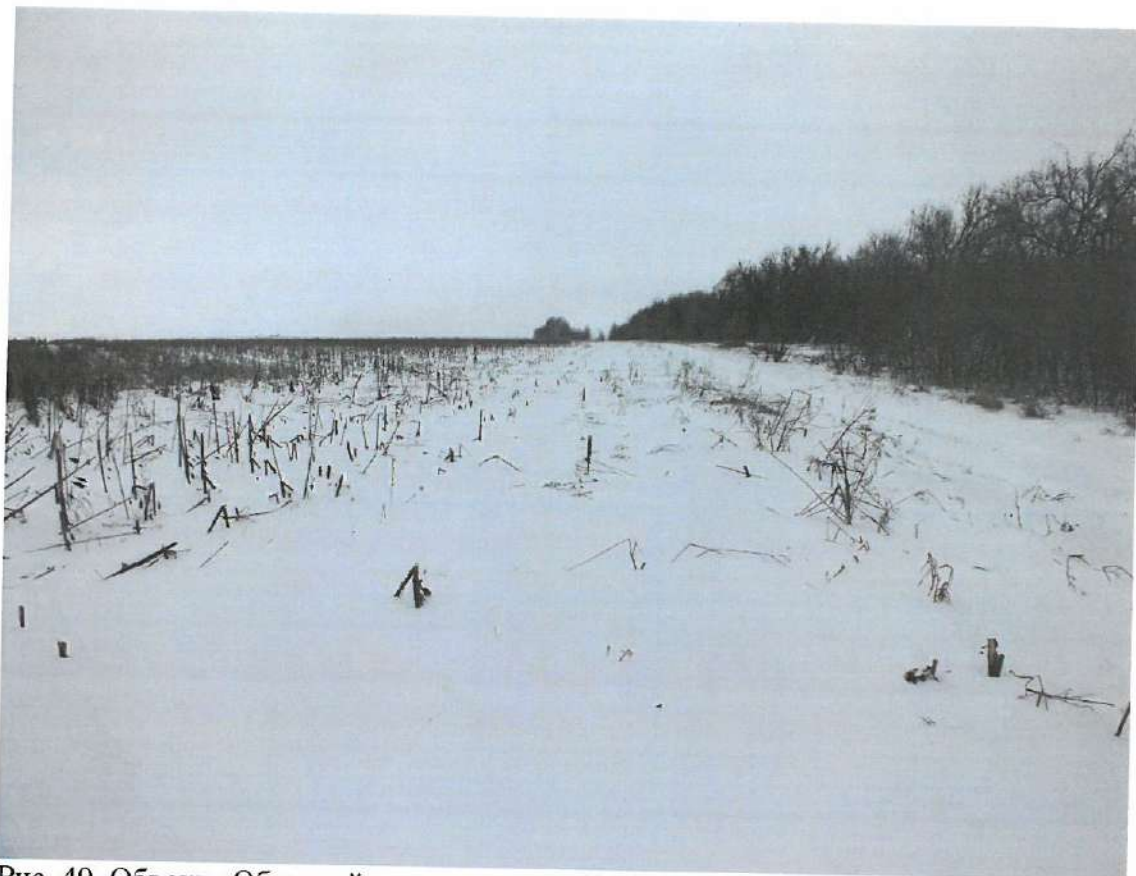
Рис. 49. Объект «Обустройство скважины № 25 Токолянского месторождения». Выкидной трубопровод и ВЛ. Вид с ЮЗ.
