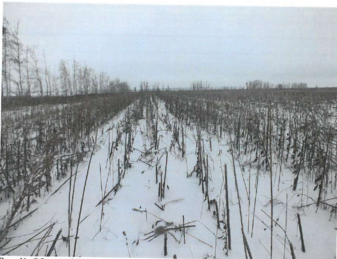
Рис. 41. Объект «Обустройство скважины № 25 Токолянского месторождения». Выкидной трубопровод и ВЛ. Вид с ЮЗ.
