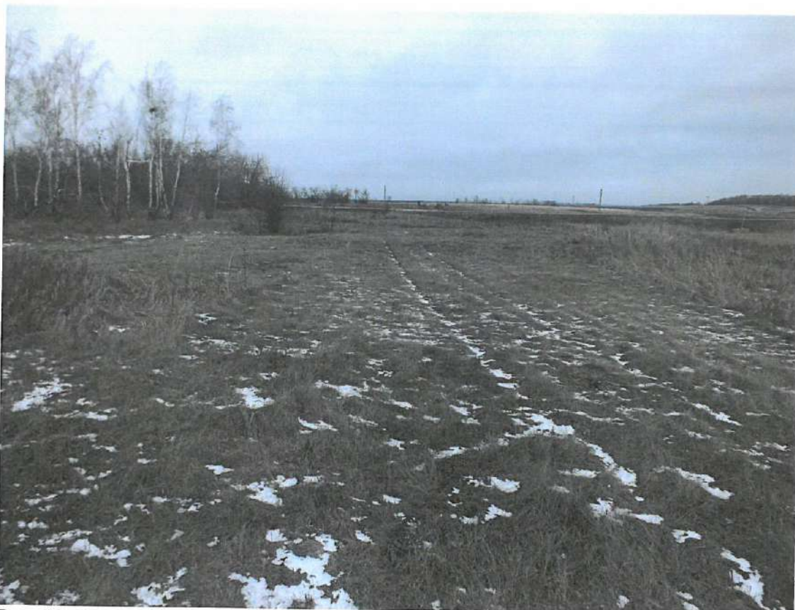
Рис. 13. Объект «Обустройство скважины № 25 Токолянского месторождения». Выкидной трубопровод и ВЛ. Вид с ЮЮВ.
