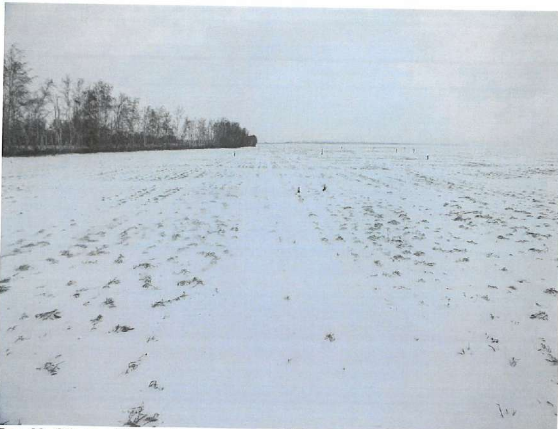
Рис. 23. Объект «Обустройство скважины № 25 Токолянского месторождения». Выкидной трубопровод и ВЛ. Вид с ЮЮЗ.
