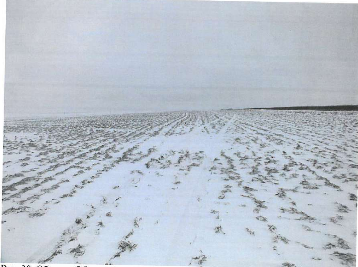
Рис. 30. Объект «Обустройство скважины № 25 Токолянского месторождения». Выкидной трубопровод и ВЛ. Вид с ЗСЗ.
