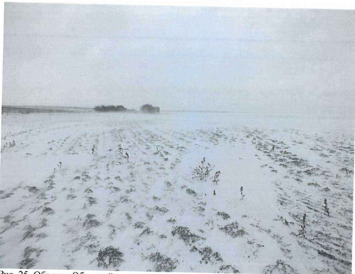
Рис. 25. Объект «Обустройство скважины № 25 Токолянского месторождения». Выкидной трубопровод и ВЛ. Вид с ЮЮЗ.
