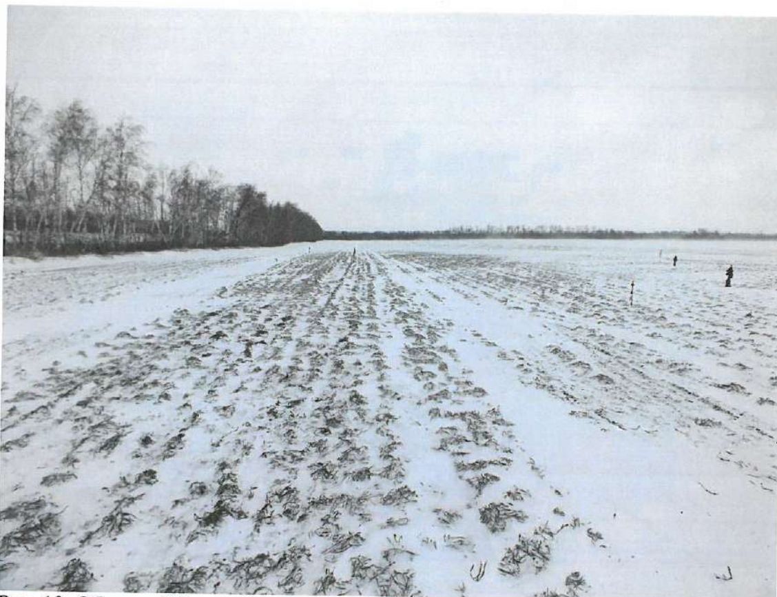
Рис. 19. Объект «Обустройство скважины № 25 Токолянского месторождения». Выкидной трубопровод и ВЛ. Вид с ЮЮЗ.
