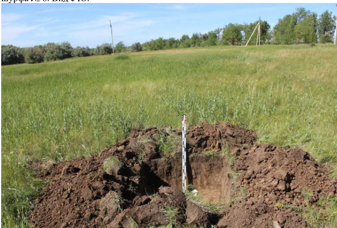
Рис. 45. Объект «Техническое перевооружение нефтегазосборного трубопровода от АГЗУ-5 Веселого месторождения до точки врезки ...». Рекогносцировочный шурф № 6. Вид с Ю.
