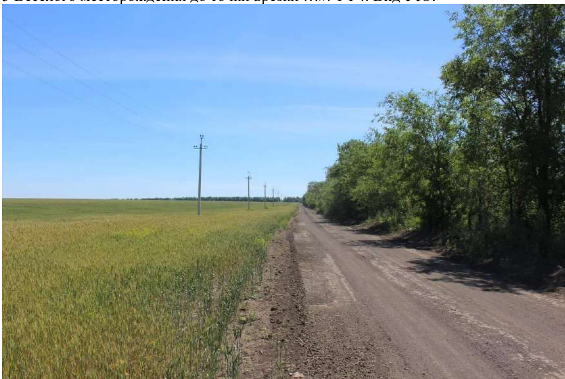
Рис. 13. Объект «Техническое перевооружение нефтегазосборного трубопровода от АГЗУ-5 Веселого месторождения до точки врезки ...». ТФ4. Вид с С.
