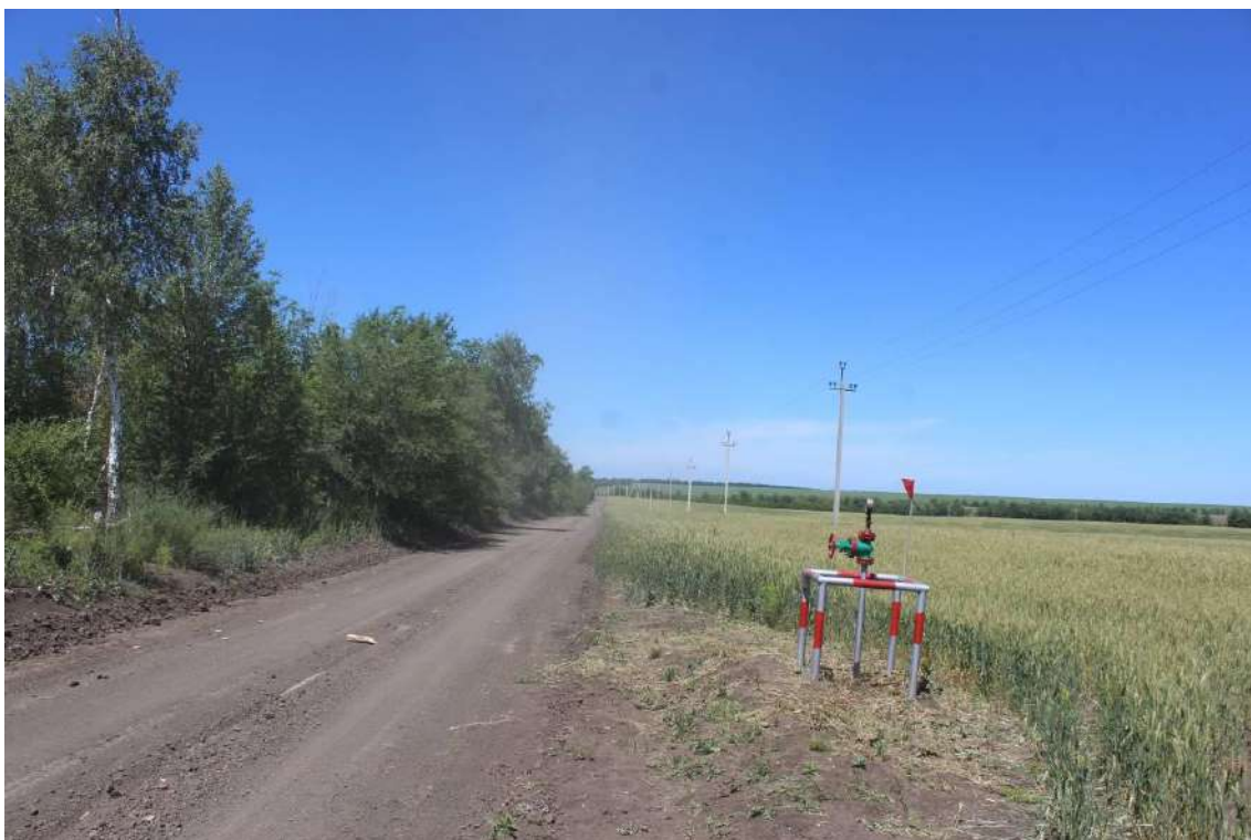
Рис. 10. Объект «Техническое перевооружение нефтегазосборного трубопровода от АГЗУ-5 Веселого месторождения до точки врезки ...». ТФЗ. Вид с Ю.
