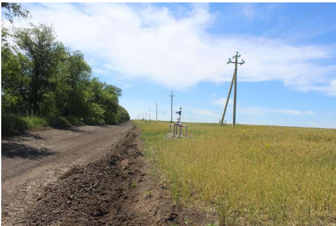
Рис. 16. Объект «Техническое перевооружение нефтегазосборного трубопровода от АГЗУ-5 Веселого месторождения до точки врезки ...». ТФб. Вид с В.
