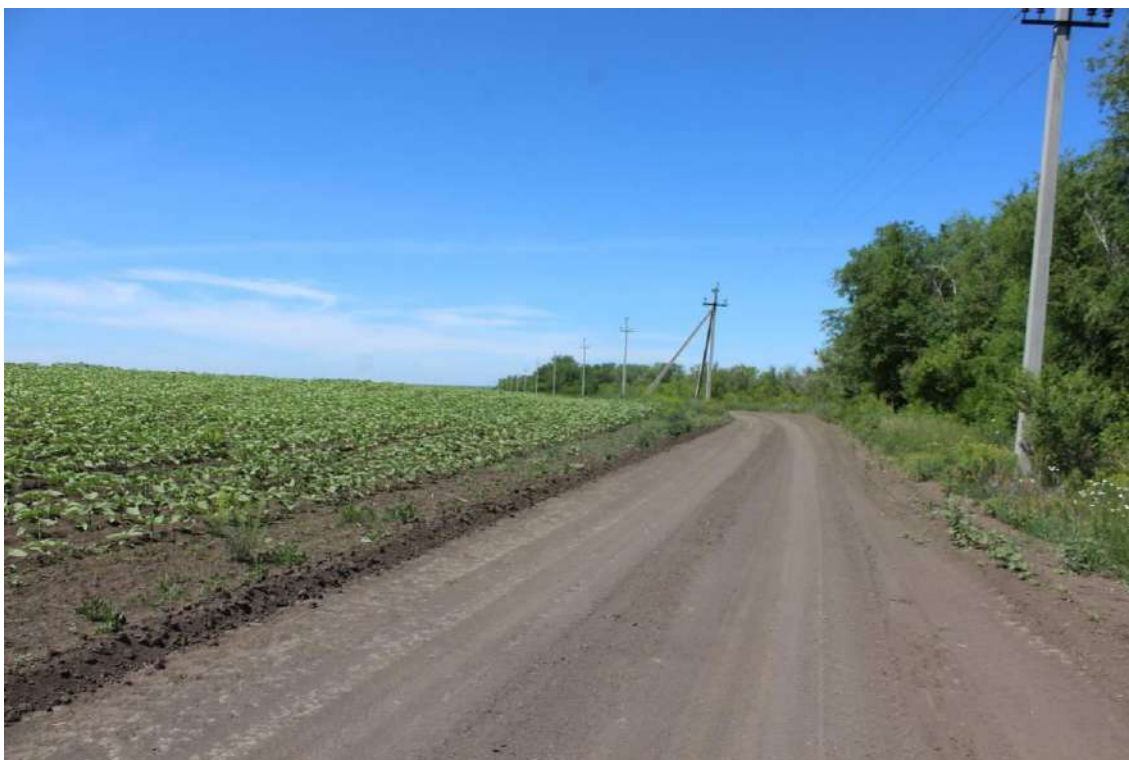
Рис. 8. Объект «Техническое перевооружение нефтегазосборного трубопровода от АГЗУ-5 Веселого месторождения до точки врезки ...». ТФ2. Вид с ЮВ.
