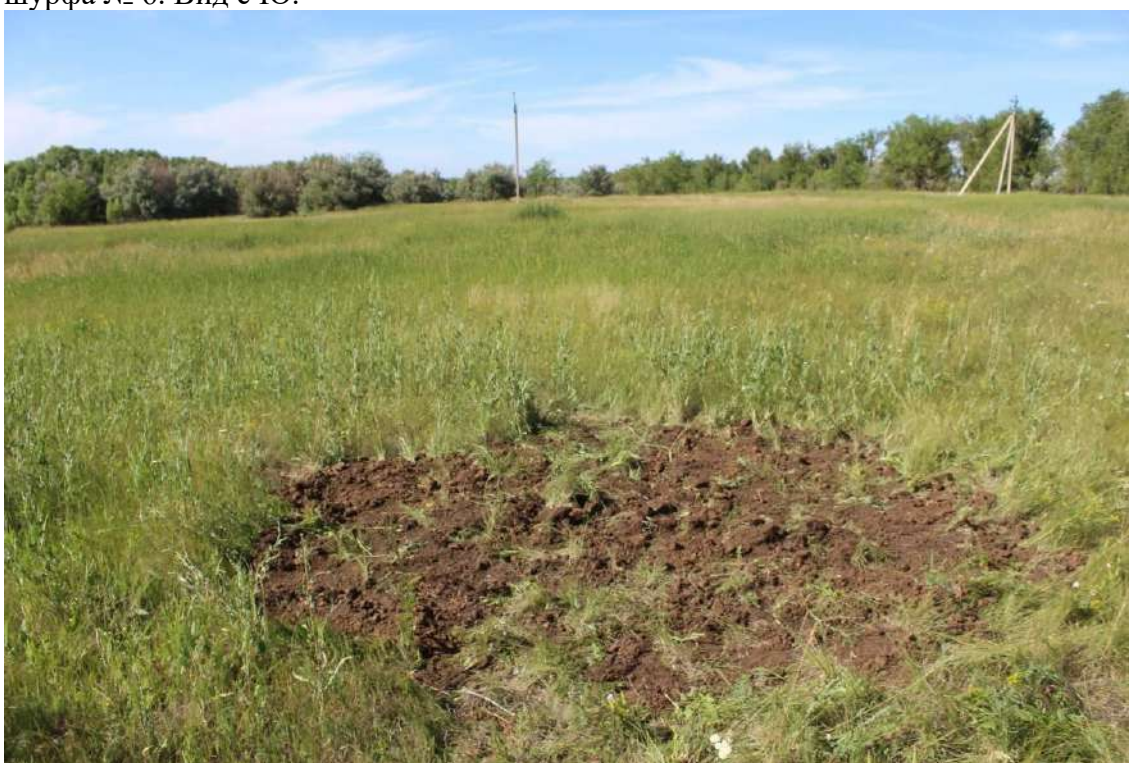
Рис. 47. Объект «Техническое перевооружение нефтегазосборного трубопровода от АГЗУ-5 Веселого месторождения до точки врезки ...». Рекультивация рекогносцировочного шурфа № 6. Вид с Ю.
