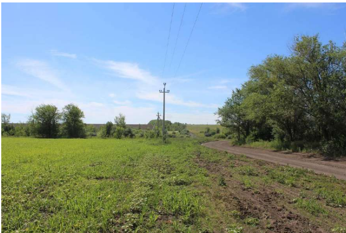
Рис. 18. Объект «Техническое перевооружение нефтегазосборного трубопровода от АГЗУ-5 Веселого месторождения до точки врезки ...». ТФ7. Вид с В.
