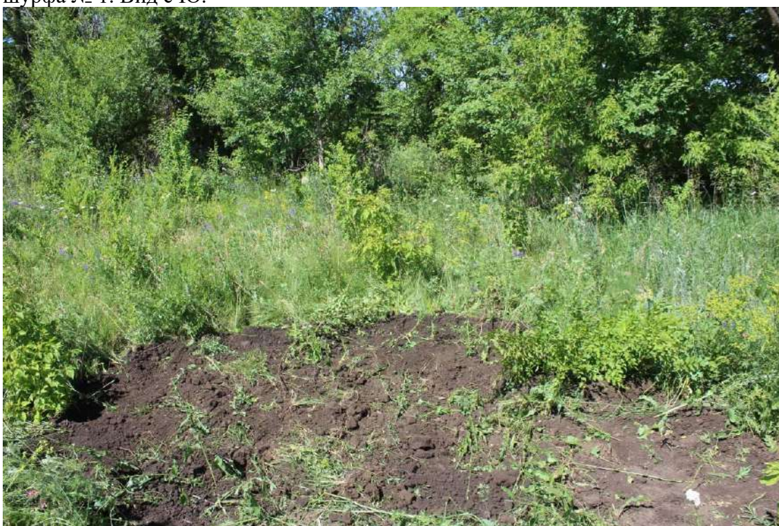
Рис. 27. Объект «Техническое перевооружение нефтегазосборного трубопровода от АГЗУ-5 Веселого месторождения до точки врезки ...». Рекультивация рекогносцировочного шурфа № 1. Вид с Ю.
