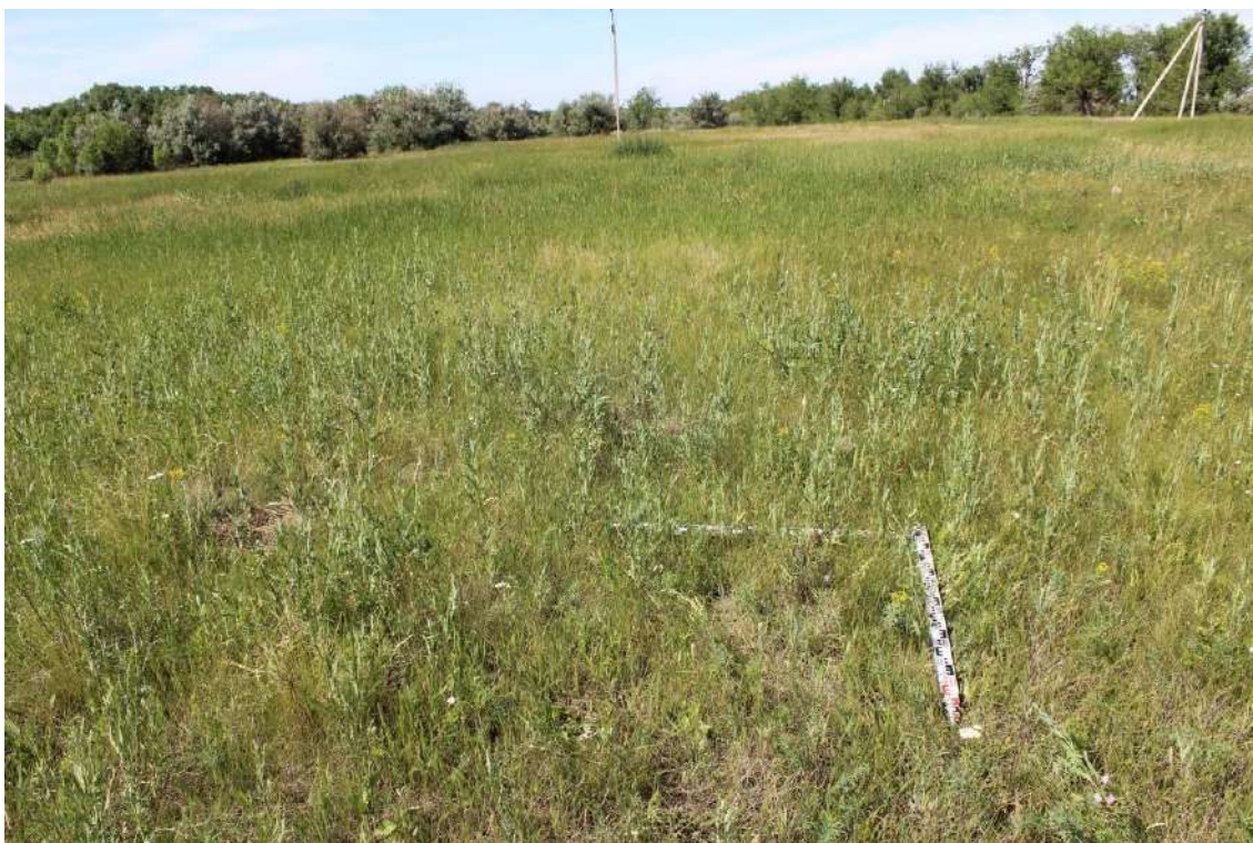
Рис. 44. Объект «Техническое перевооружение нефтегазосборного трубопровода от АГЗУ-5 Веселого месторождения до точки врезки ...». Место закладки рекогносцировочного шурфа № 6. Вид с Ю.
