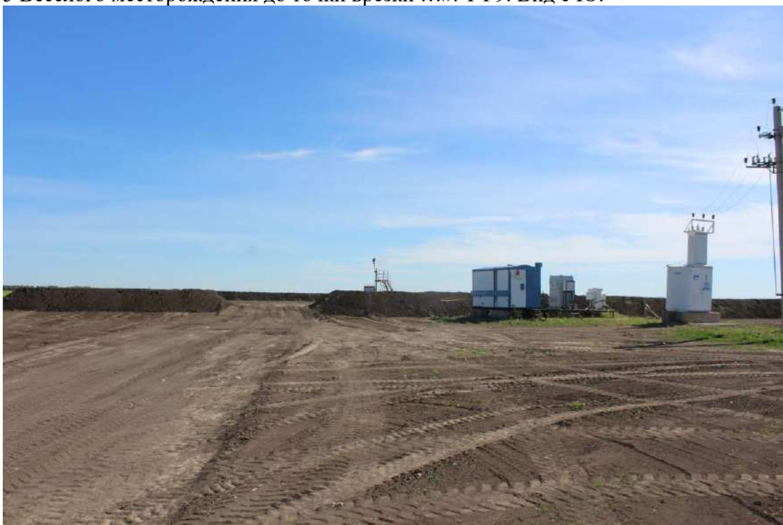
Рис. 23. Объект «Техническое перевооружение нефтегазосборного трубопровода от АГЗУ-5 Веселого месторождения до точки врезки ...». ТФ9. Вид с С.
