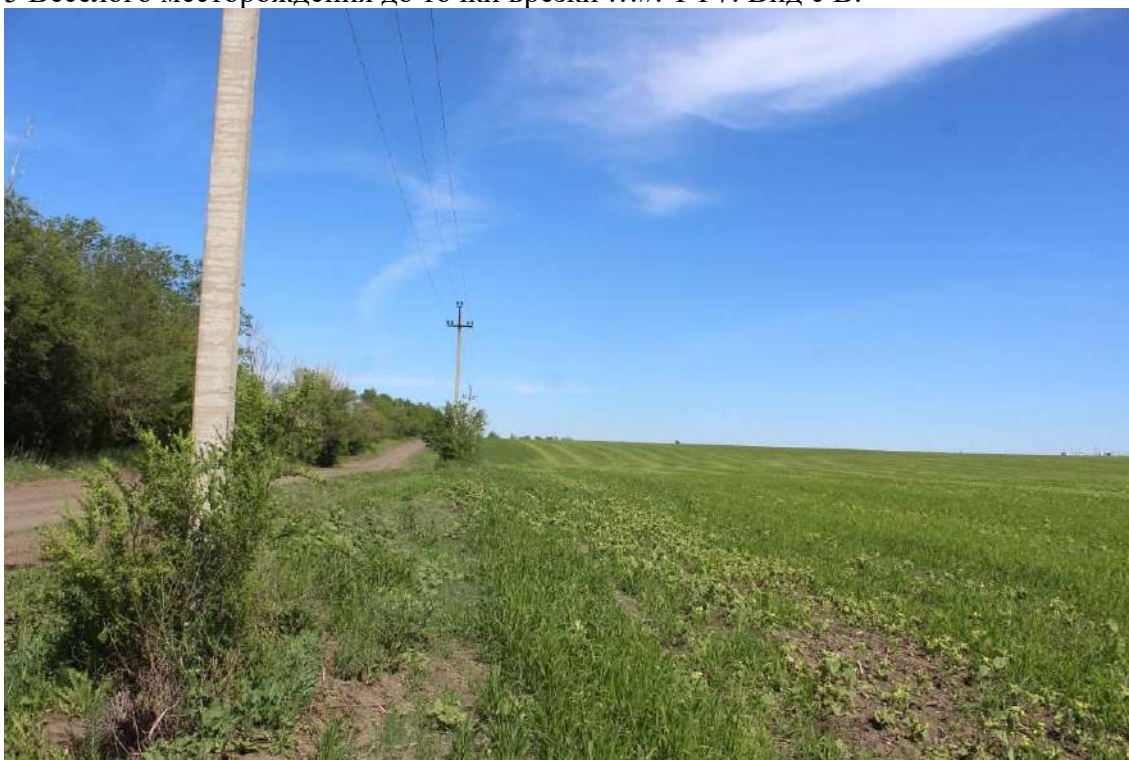
Рис. 19. Объект «Техническое перевооружение нефтегазосборного трубопровода от АГЗУ-5 Веселого месторождения до точки врезки ...». ТФ7. Вид с З.
