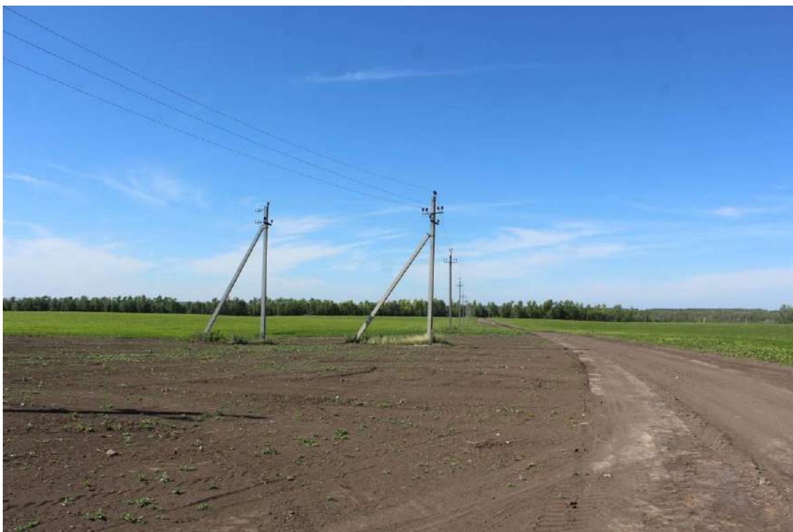
Рис. 22. Объект «Техническое перевооружение нефтегазосборного трубопровода от АГЗУ-5 Веселого месторождения до точки врезки ...». ТФ9. Вид с Ю.
