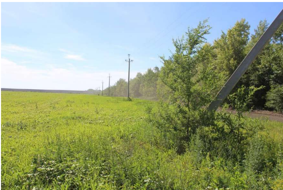
Рис. 20. Объект «Техническое перевооружение нефтегазосборного трубопровода от АГЗУ-5 Веселого месторождения до точки врезки ...». ТФ8. Вид с В.
