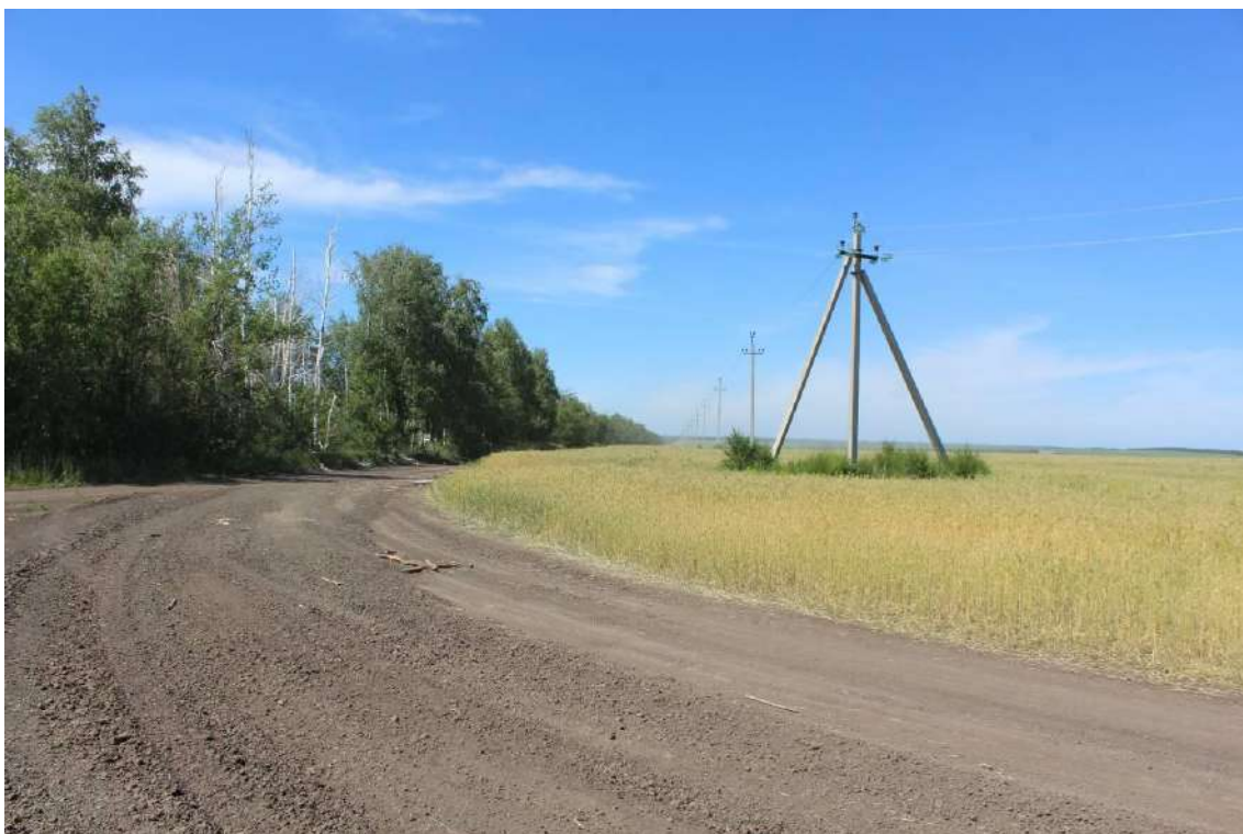
Рис. 14. Объект «Техническое перевооружение нефтегазосборного трубопровода от АГЗУ-5 Веселого месторождения до точки врезки ...». ТФ5. Вид с Ю.
