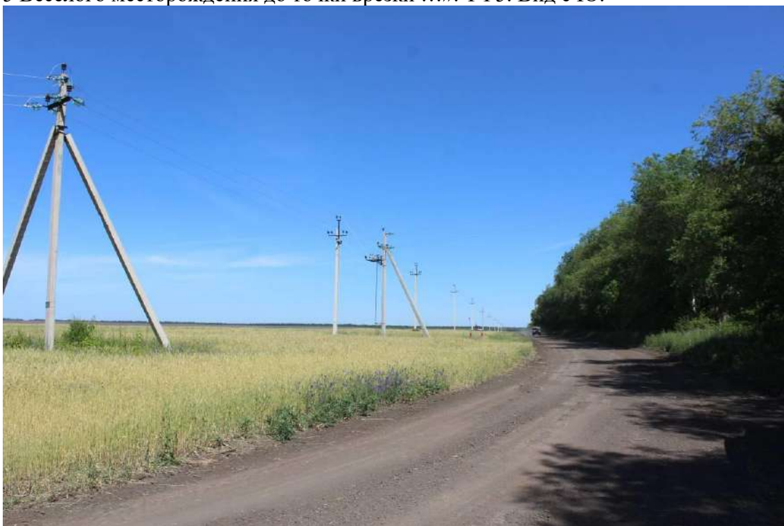
Рис. 15. Объект «Техническое перевооружение нефтегазосборного трубопровода от АГЗУ-5 Веселого месторождения до точки врезки ...». ТФ5. Вид с З.
