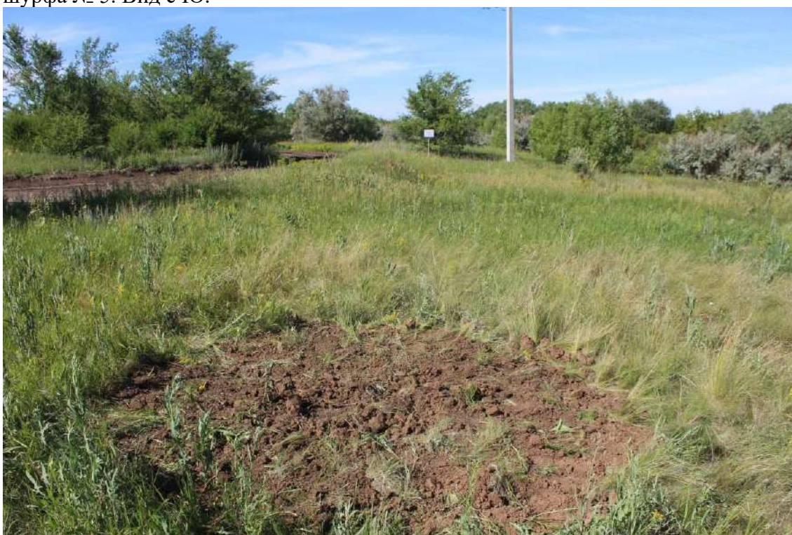
Рис. 43. Объект «Техническое перевооружение нефтегазосборного трубопровода от АГЗУ-5 Веселого месторождения до точки врезки ...». Рекультивация рекогносцировочного шурфа № 5. Вид с Ю.
