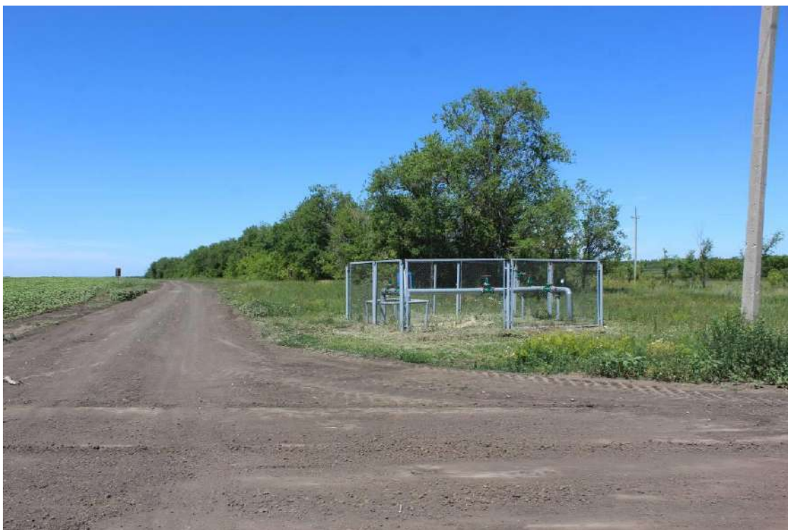
Рис. 6. Объект «Техническое перевооружение нефтегазосборного трубопровода от АГЗУ-5 Веселого месторождения до точки врезки ...». ТФ1. Вид с ЮВ.
