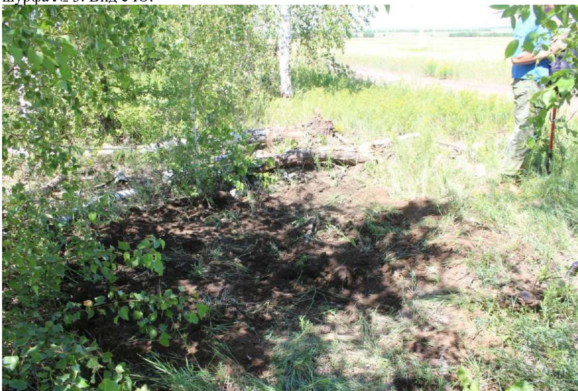
Рис. 35. Объект «Техническое перевооружение нефтегазосборного трубопровода от АГЗУ-5 Веселого месторождения до точки врезки ...». Рекультивация рекогносцировочного шурфа № 3. Вид с Ю.
