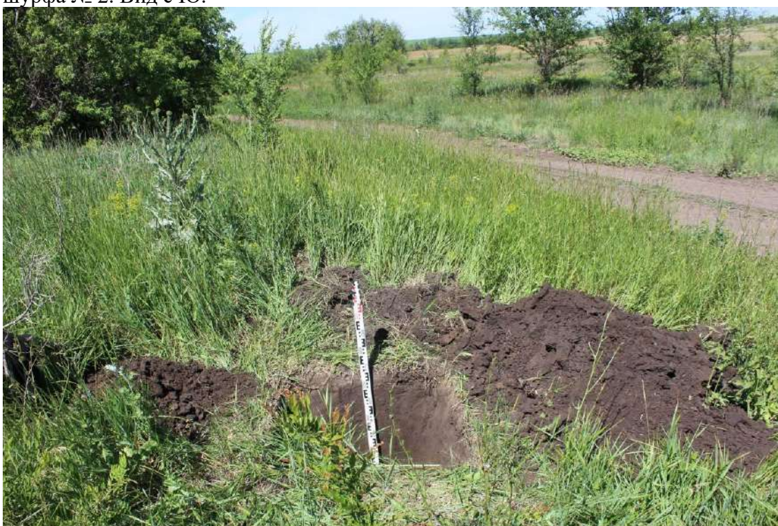
Рис. 29. Объект «Техническое перевооружение нефтегазосборного трубопровода от АГЗУ-5 Веселого месторождения до точки врезки ...». Рекогносцировочный шурф № 2. Вид с Ю.
